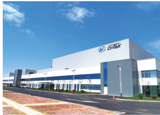
▲德州基地 山东有研半导体材料有限公司 2020年启用
