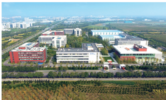
▲怀柔基地 有色金属新材料科技园 2019年启用
